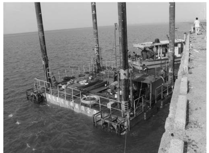
固定架(使用時機) 適合水流湍急之河道及海上，地層為砂土層、岩層及卵礫石層須作岩心取樣之鑽孔。
