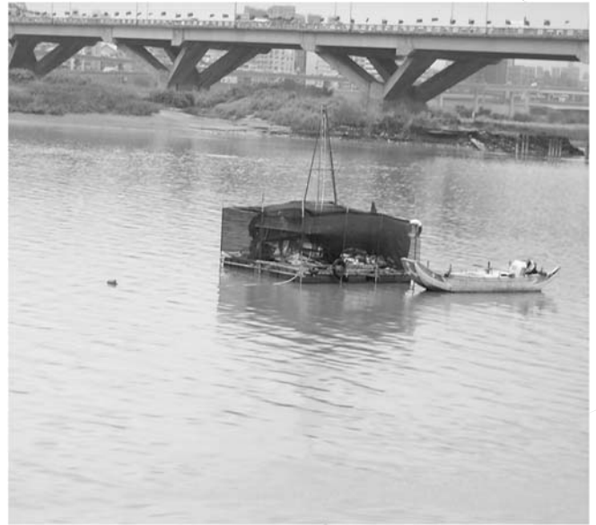
浮台 (水上鑽探機場捷運線-垮淡水河段)
