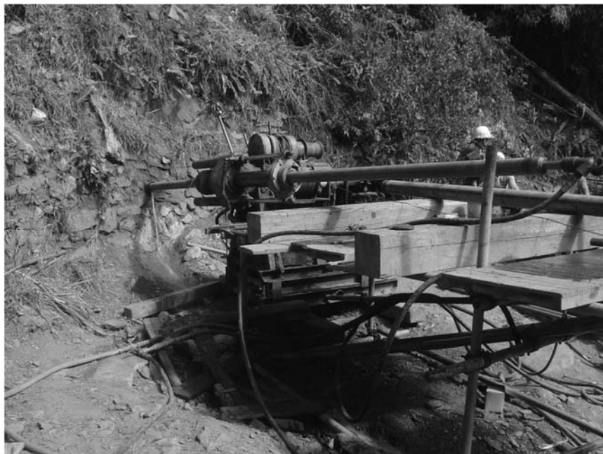
旋轉式取樣鑽機(水平鑽孔)
