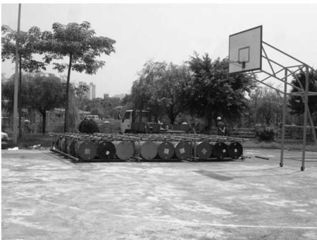
浮台(使用時機) 適合水流平靜如湖泊或港內，地層為砂土層不作岩心取樣之鑽孔。
