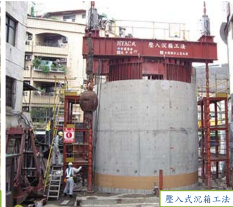
壓入式沉箱工法
